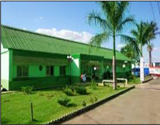
Visitas técnicas em Hospital Municipal Thuany Garcia Ribeiro Piracanjuba – GO, realizada em 12/01/2021
